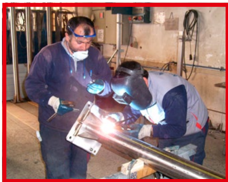
Metināšanas posteņus nenodrošinot ar ērti regulējamu un pārvietojamu atsūces ventilāciju, kā arī nelietojot individuālās aizsardzības līdzekļus, ievērojami paaugstinās risks saslimt ar aroda audzējiem
